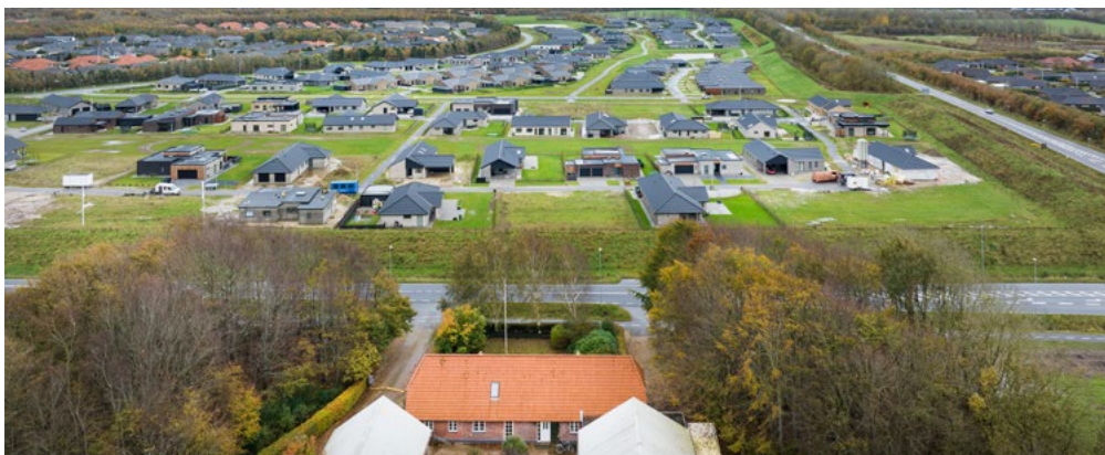
Neptunvænget og Plutovænget ved Sønderriis med ejendommen på Guldagervej 92 i forgrunden.
